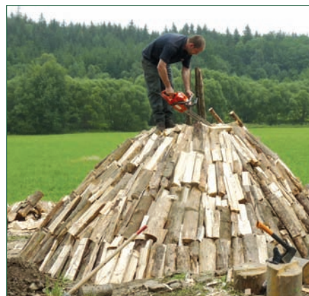
Stavba milíře (Pec pod Čerchovem - Dřevorubecké slavnosti 2009).
